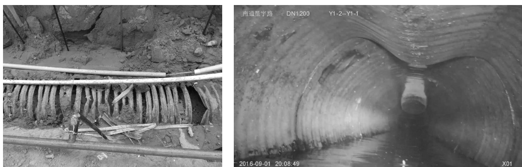
图 1 管道破损情况现场照片
